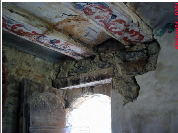
20. Détail encastrement des solives
