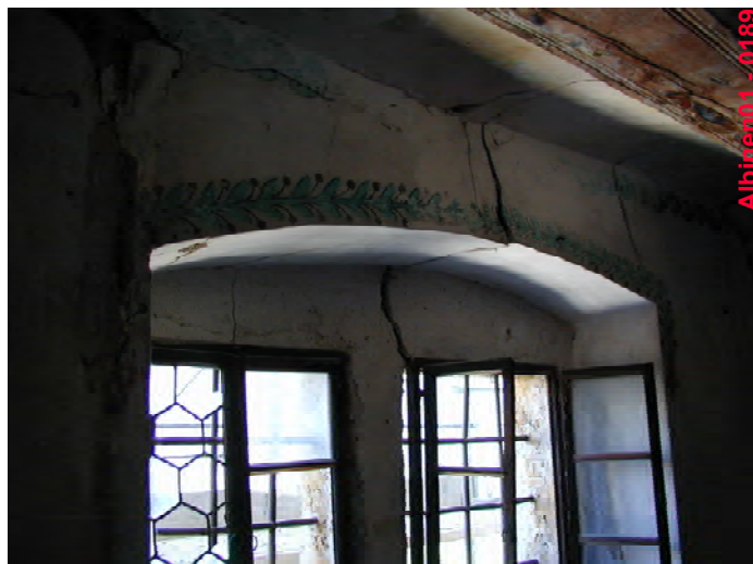
19. Fenêtre jumelée, partie haute
