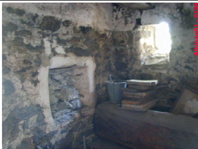
13. Fenêtres du rez-de-chaussée
