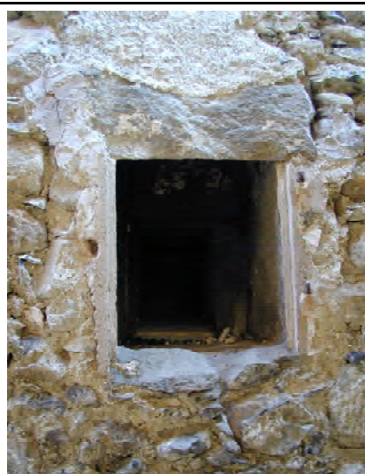
11. Façade sud, ouverture à l'arrière du fourneau
