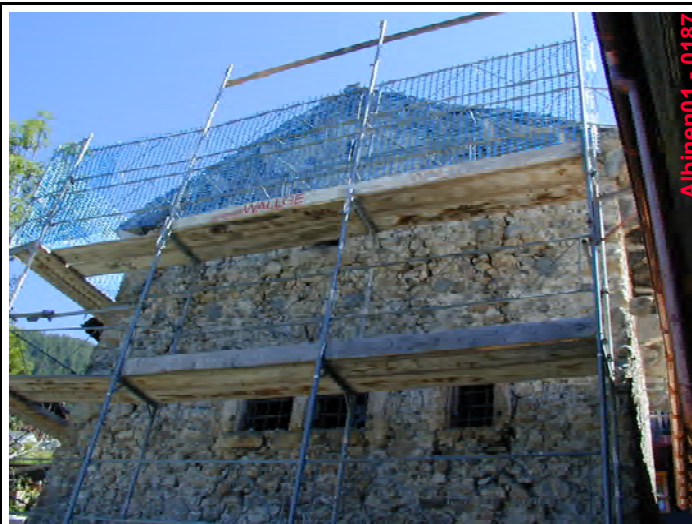
08. Façade ouest, partie haute
