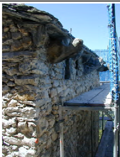
05. Façade nord, partie haute
