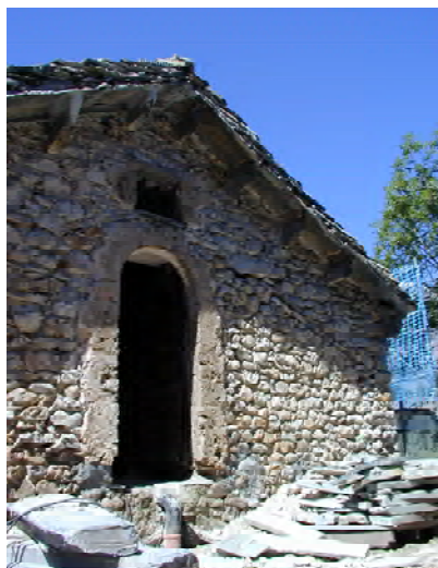
04. Façade est, partie nord
