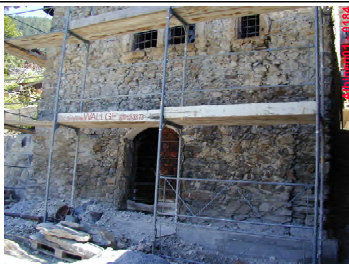
07. Façade ouest, partie basse
