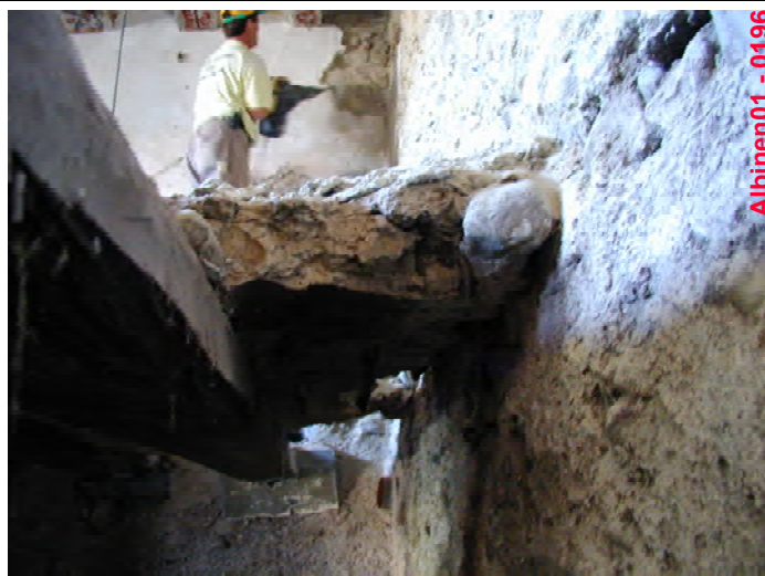
15. Détail de la dalle de mortier
